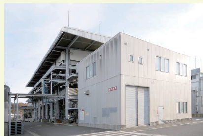
臭素化工場外観
